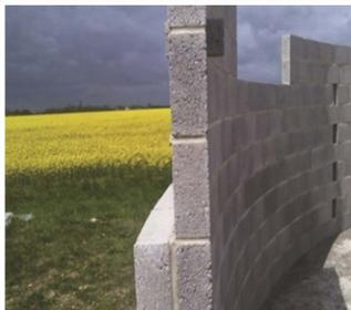
Los bloques de hormigón se dividen en bloques de baja y alta densidad, desde los 520 a los 1950 kg/m<sup>3</sup>. Son materiales de construcción que pueden contener diferentes corrientes de residuos:
