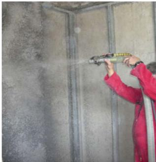
El aislamiento de celulosa reciclada proviene de papel ya utilizado que es mezclado con diferentes aditivos (sal borax, ácido bórico u otros) para obtener características ignífugas y antifúngicas requeridas.
