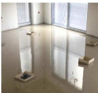
El mortero autonivelante (de cemento o de anhidrita) es un mortero de consistencia muy líquida que hace que el mortero se auto nivele con gran facilidad. Este tipo de mortero puede contener diferentes orígenes de material reciclado tanto en el aglomerante, la arena o las adiciones:
