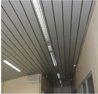
Los techos metálicos son piezas prefabricadas que utilizan como materia prima acero, aluminio, etc. Conformado en frío que habitualmente contienen un porcentaje de materia prima reciclada. Este tipo de sistemas se compone de una estructura suspendida del forjado que a su vez soporta bandejas, lamas o macrocélulas.
